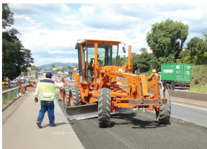
Figura 5: Execução do segmento 2 (BGTC)
