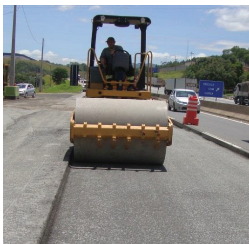
Figura 3: Execução do segmento 1 (BGS)
